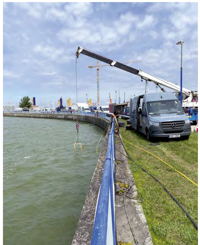
Obr. 10 Tesnenie dilatácií na spojovacom múre v Gabčíkove potápačmi s použitím tesniaceho gumeného pásu (28. 06. 2022)
