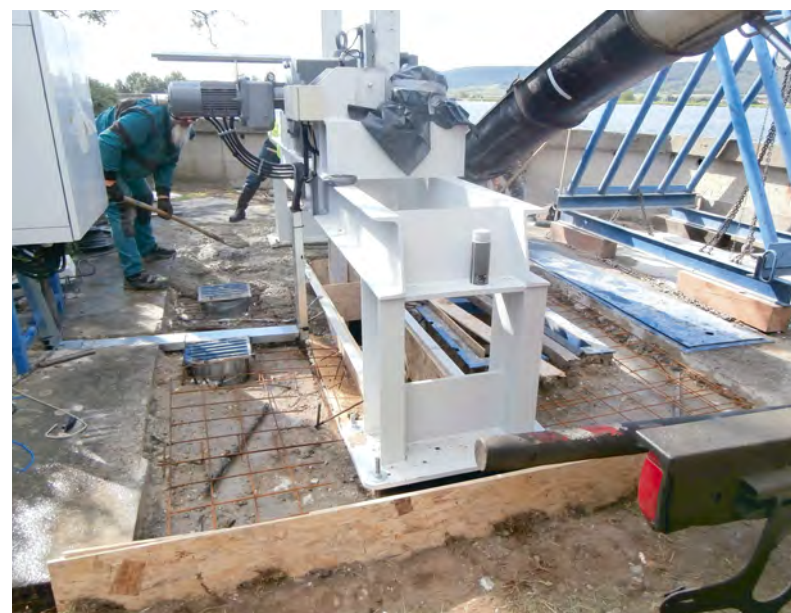
Obr. 6 Stavebné práce na nápusnom objekte
