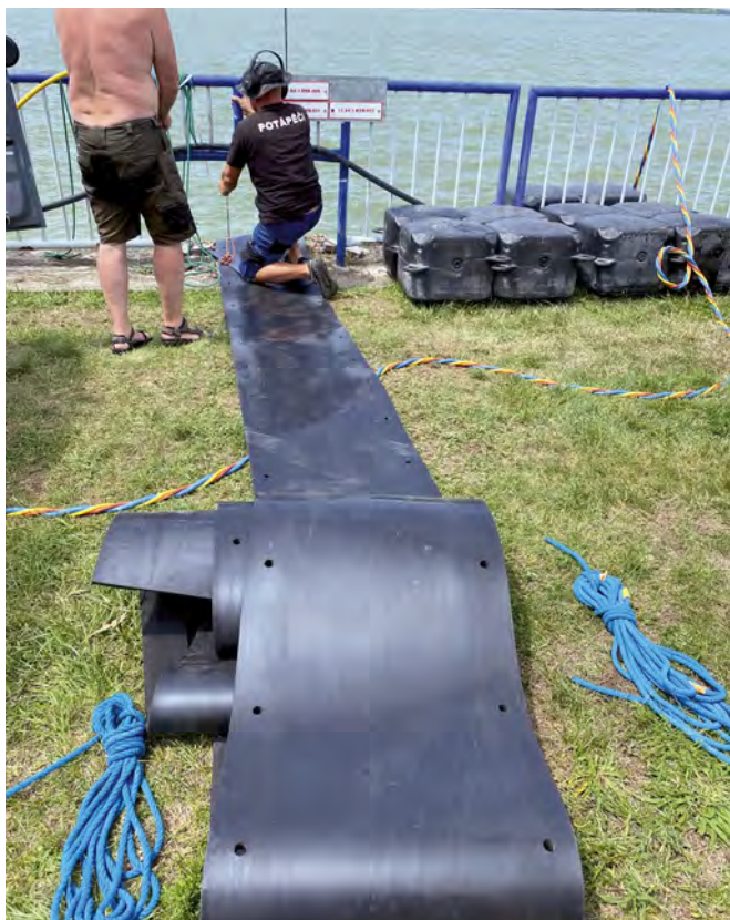
Obr. 10 Tesnenie dilatácií na spojovacom múre v Gabčíkove potápačmi s použitím tesniaceho gumeného pásu (28. 06. 2022)
