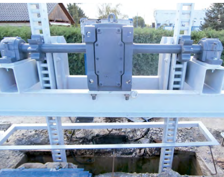
Obr. 5 Pohľad na nové stavidlo nápusného objektu do Perca
