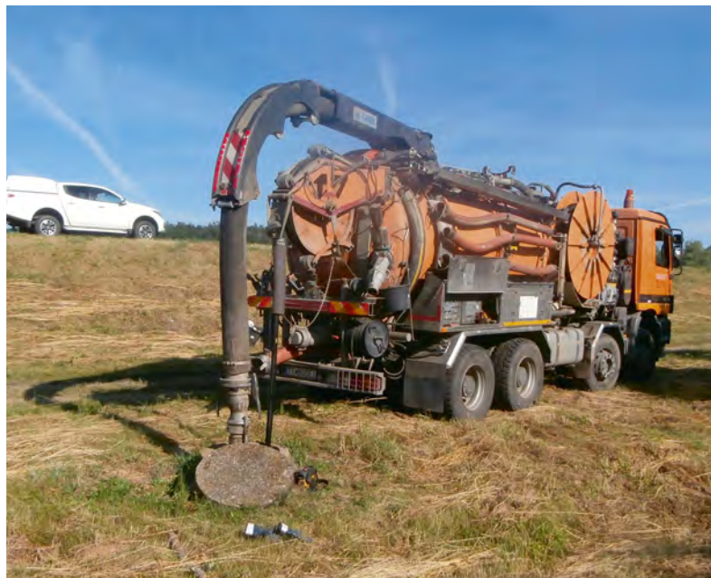
Obr. 3 Čistenie ľS priesakového drénu zo šachty
